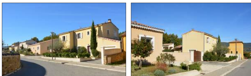
L'opération de logements locatifs aidés à la Lichère : une urbanisation à la fois plus dense et mieux intégrée.
